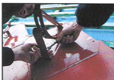
popis 8 Upevňování podpěry šroubem u které je nutno opatrně dotáhnout aby se neprotočil, strácí potom svoji pevnost
