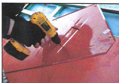
popis 4 Předvrtání pro šroub pro připevnění podpěry.
