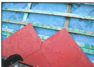
popis 2 Připravená krytina pro montáž univerzálních šablon pro stoupací plošinu
